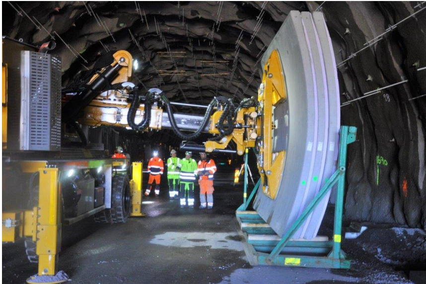
E16 Bjørum-Skaret, Elektrisk montering av tunnelvegger
