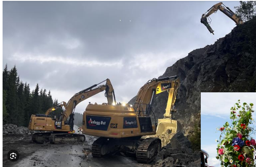
Rv 4 Almenningsdelet - Lygnebakken | Anlegg Øst Entreprenør
